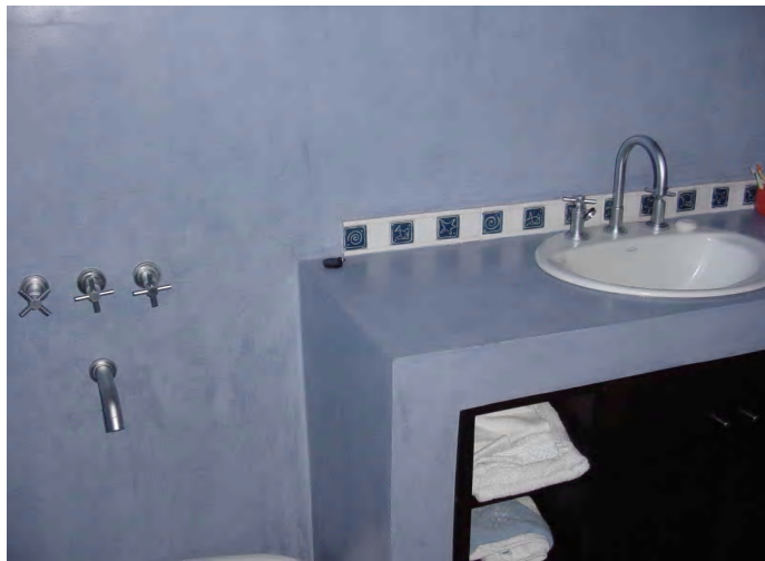
Uso de Estuco Bomanite en cuartos de baño sobre baldosas existentes.
