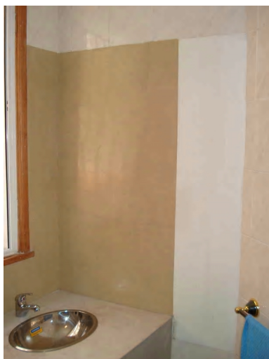
Estuco Sand base blanca sobre cerámico.
