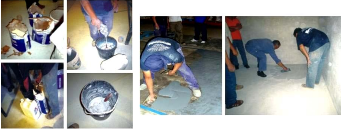
Presentación del producto, Preparación e instalación con llana.
